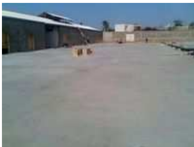
Dallage devant recevoir la charpente.
