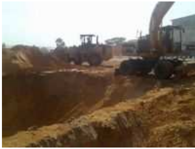
Excavation Bassin d'aération de la STEP
