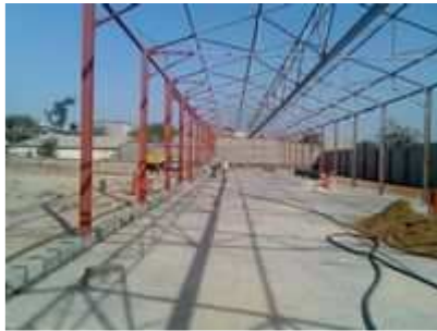
Hangar à rénover phase sablage
