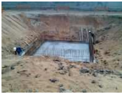
Radier du bassin d'aération
