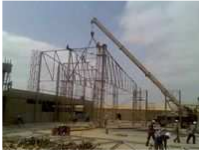
Démarrage du montage de la charpente métallique.
