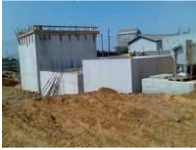
Station d'épuration de l'usine Philip Morris en construction.
